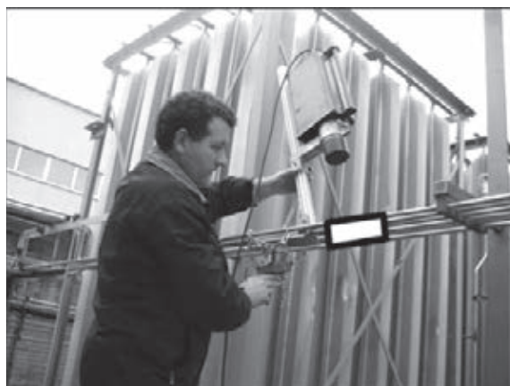
Рис. 2. Размещение РТВ-03 на четырехниточном трубопроводе
