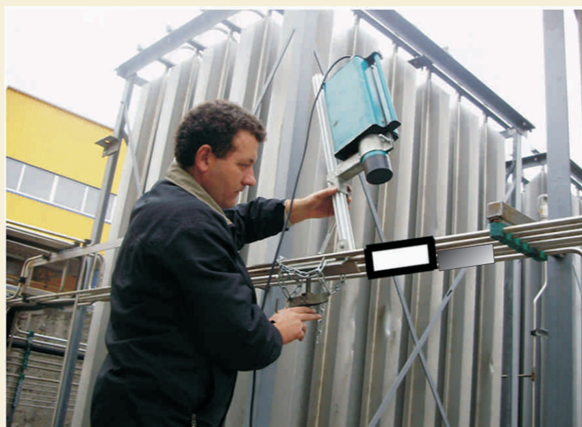
Размещение портативной Ф/Р аппаратуры на четырехточечном трубопроводе
