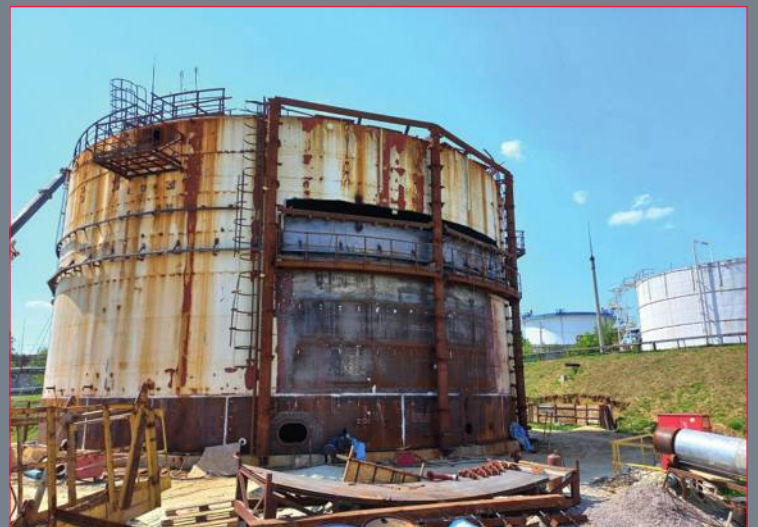
PBC 5000 під час ремонту
