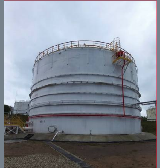
PBC 5000 після ремонту
